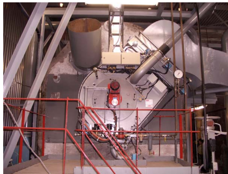
Котельная: ОАО «Мытищинская теплосеть», Мытищи. Котел КВ-ГМ 23,26 газ-мазут
