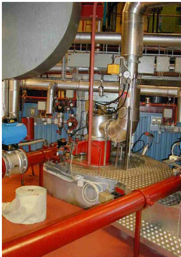
Перевод 40 МВт угольного котла
