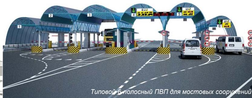
Типовой 6-полосный ПВП для мостовых сооружений
