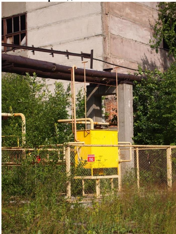
**Газопровод, мощность 195 м<sup>3</sup>/час**
